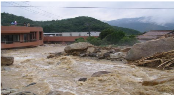
図1 老人福祉施設1階を埋めた土砂 (平成 21 年 7 月中国・九州北部豪雨) (撮影提供:国土交通省中国整備局)
