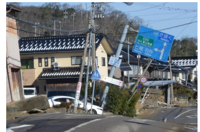
内灘町西荒屋地内（液状化）
