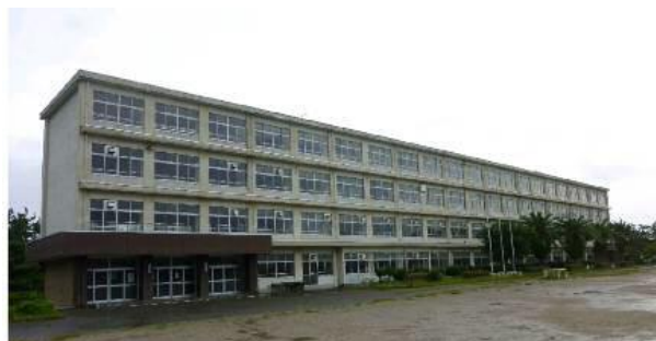
津波避難ビル（静岡県浜松市） ※浜松市HPより
