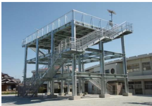
津波避難タワー（静岡県浜松市） ※浜松市HPより
