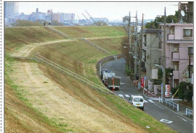
東京都の安全を守る高さ約10mの荒川の堤防
