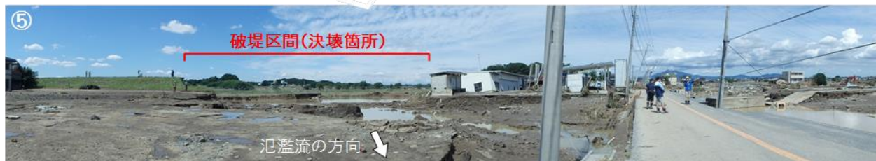
⑤ 決壊箇所周辺の被害状況：氾濫流の流れが速かった地域では、住家が傾斜や流出するなどの大きな被害が見られる
