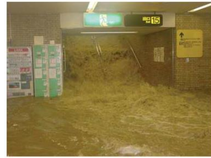
地下街の浸水状況 H15.7福岡水害(博多駅)
