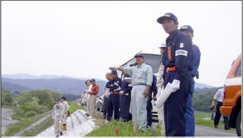
天竜川上流河川事務所における重要水防箇所の共同点検
