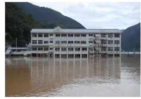
H26. 8 避難所2階の浸水 (徳島県)
