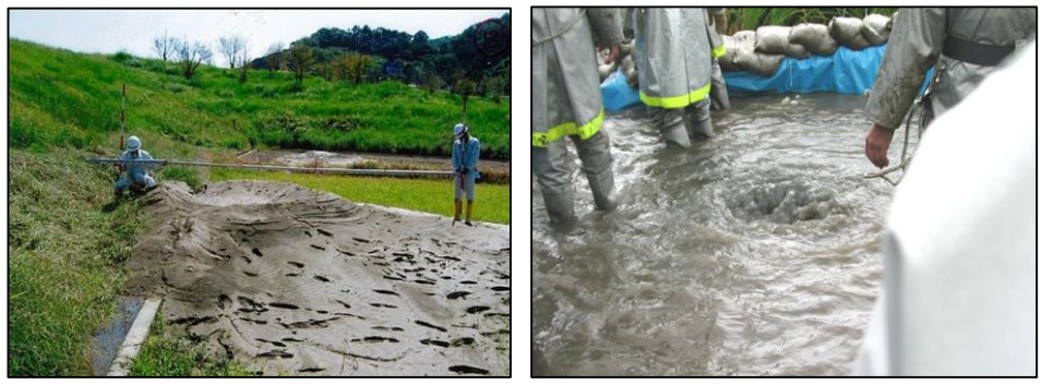
洪水時の堤防等の漏水
