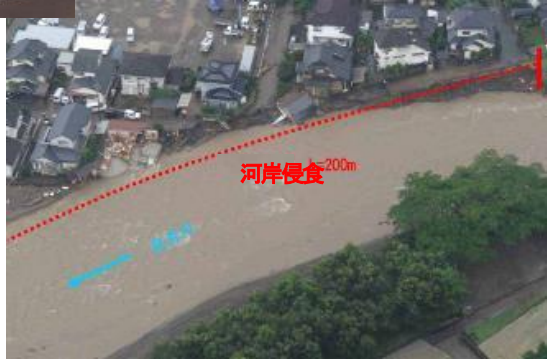
河岸侵食に伴う家屋倒壊等
