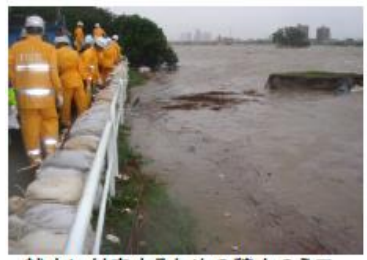
越水に対応するための積土の土工
