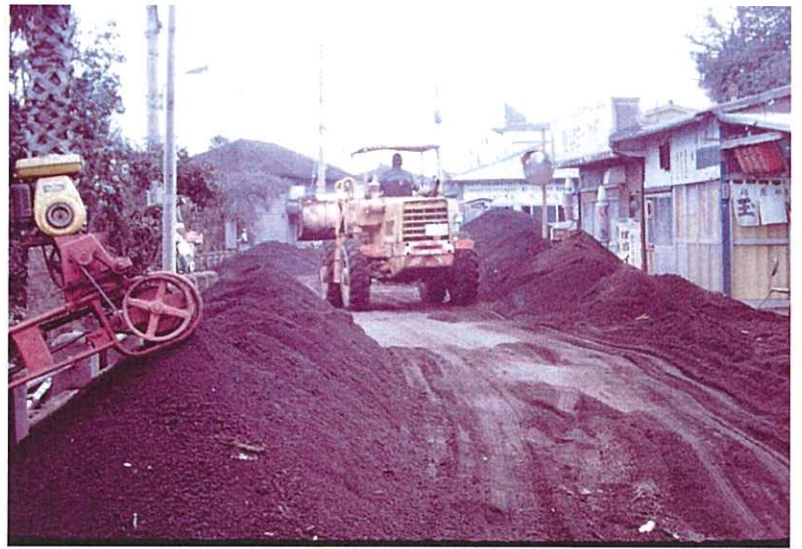
道路上の火山灰除去 住宅の屋根から排出された火山灰も交じる
