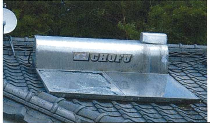
・最大で直径2cmの小さな噴石が落下 ・太陽熱温水器や 太陽電池パネル が破損
